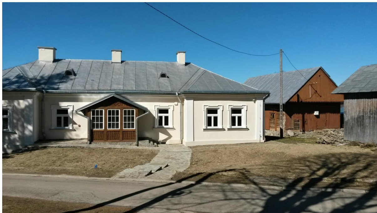
Fot. 32. Zabytkowa murowana plebania z 1890 roku w otoczeniu drewnianej zabudowy Jaślik
