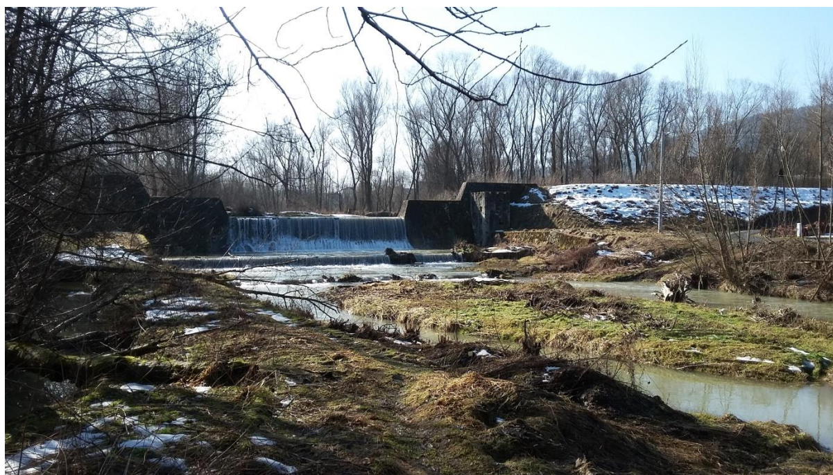
Fot. 6. Zabudowa hydrotechniczna Lubieńki
