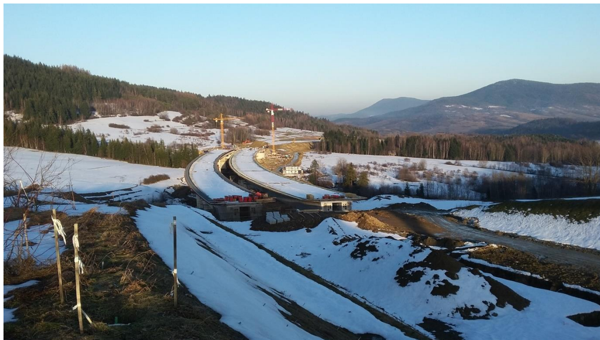
Fot. 5. Antropogeniczne przekształcenia rzeźby w związku z budową drogi szybkiego ruchu S7. Po prawej – masyw Kiczory
